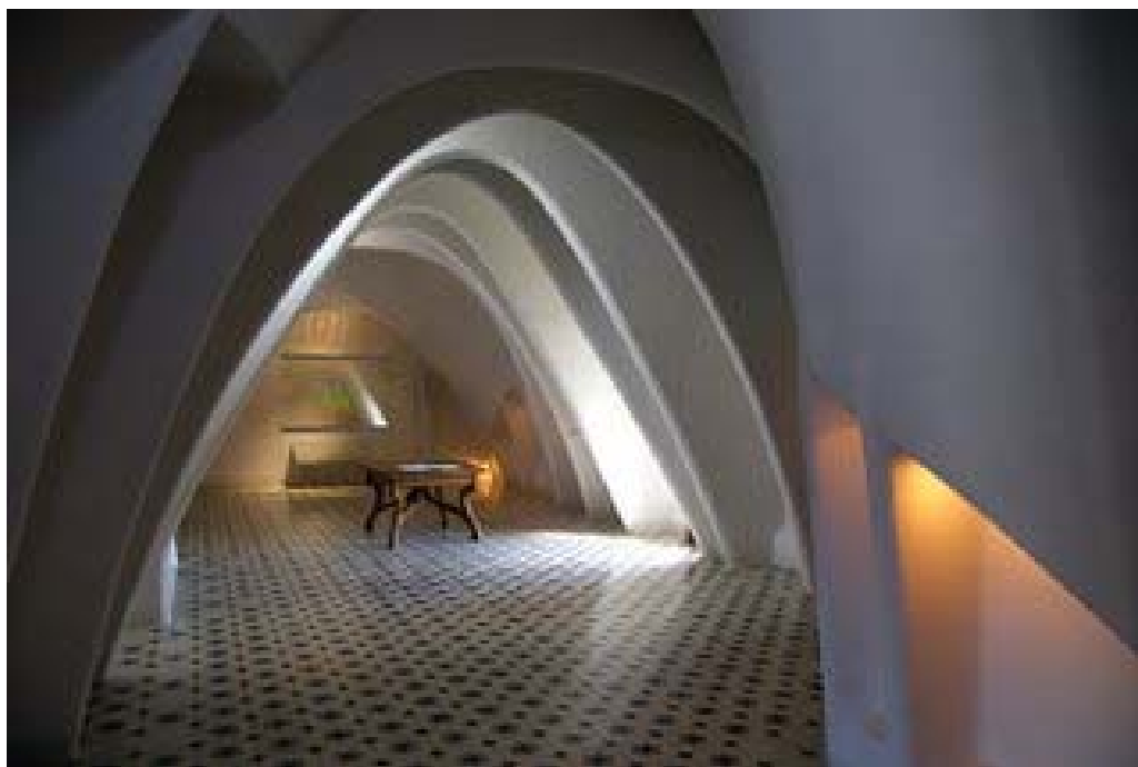
Figura 14: Arcos catenarios en los desvanes de la casa Batlló
