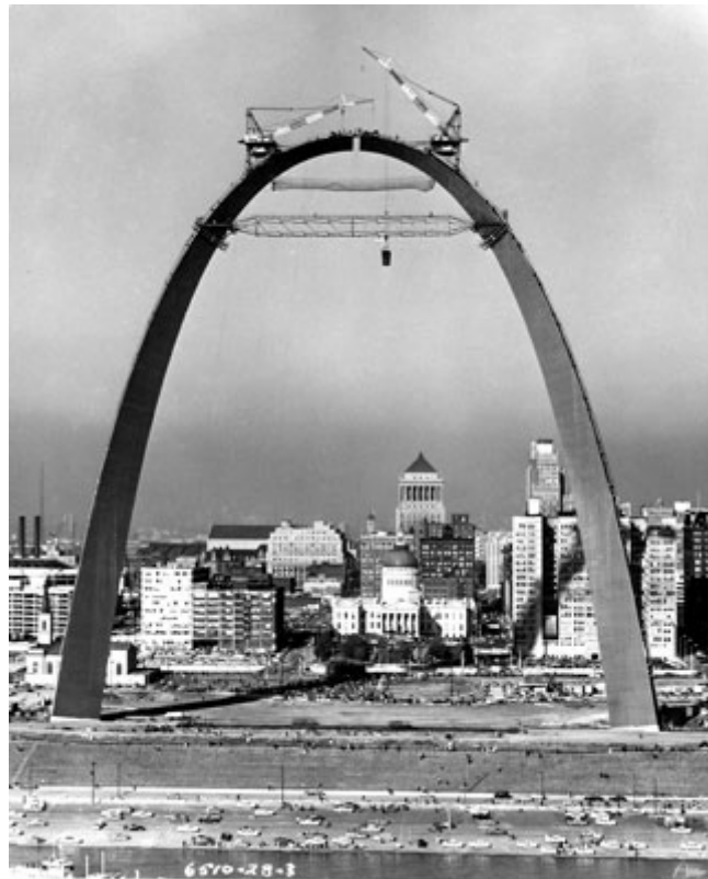
Figura 17: Gateway Arch. Fase final de la construcción
