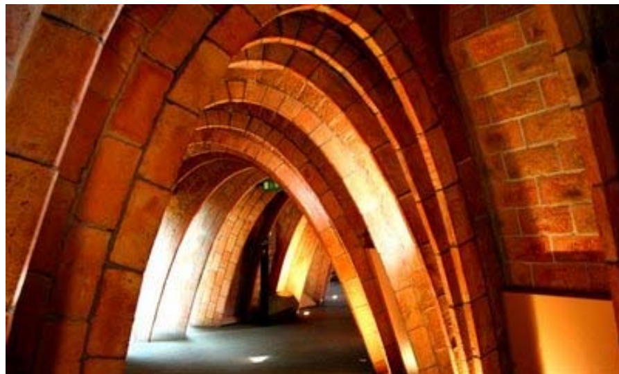
Figura 16: Arcos catenarios en buhardilla la casa Milá
