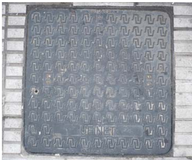
Figura 3. Tapa de registro UFINET
